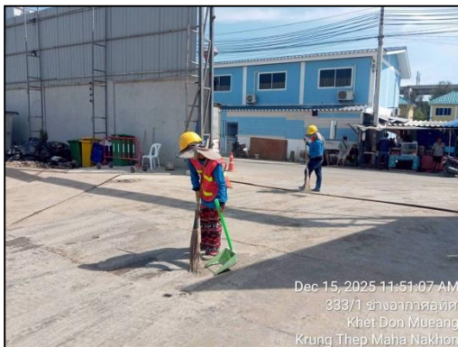
รูปที่ 7 คนงานคอยฉีดพรม และกวาดเศษดิน ทราช ที่ตกหล่นบริเวณพื้นที่ก่อสร้างโครงการ
