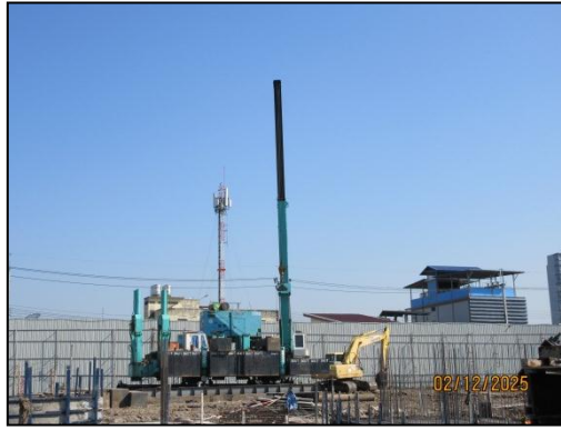
รูปที่ 4 การทำฐานรากแบบเสาเข็มกด
